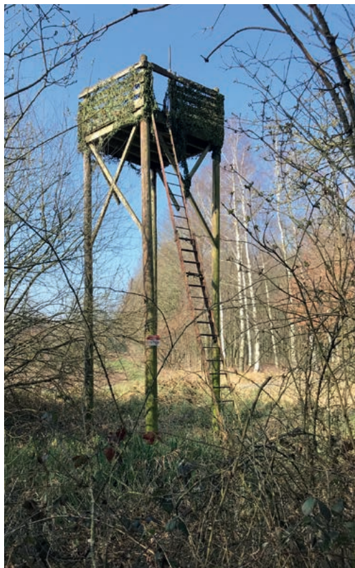
PHOTO 13 | Mirador installé en France sur la zone de chasse de l'étang Poujet. Ce dernier est situé à 5 m de la limite des marais d'Harchies et offre une vue et certainement un poste de tir de choix sur les canards s'envolant de l'étang Van Damme vers la France / Watchtower settled in France on the Poujet pond hunting area. The latter is located at 5 m from the limit of the Harchies marshes and offers a view and certainly a shooting post of choice on the ducks flying from the Van Damme pond to France (Saint-Aybert, 29.04.21, © Alain Malengreau)
