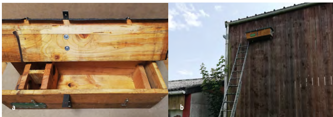
PHOTOS 6a & b | Nouveau modèle de nichoir à Chevêche utilisé en Famenne depuis 2023. Un seul niveau dans la caisse et un dispositif anti-intrusion par la fouine très performant. Modèle utilisé localement en Flandre (L. Momerency) et aux Pays-Bas (J. Ter Stege) / New model of Little Owl nesting box used in Famenne since 2023. A single level in the box and a very effective anti-intrusion device for martens. Model used locally in Flanders (L. Momerency) and the Netherlands (J. Ter Stege) (Belvaux, 10.07.2023, Francis Bathy)
